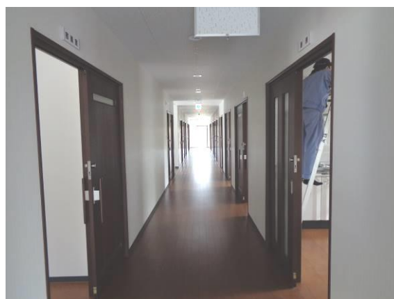
12 廊下全景（玄関から）
